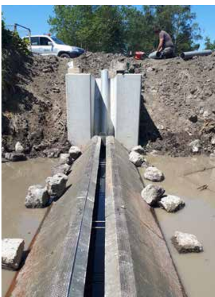
(1) Belgische Schlitzfalle im Bauzustand (Foto: Paul Van Loon / VMM)
